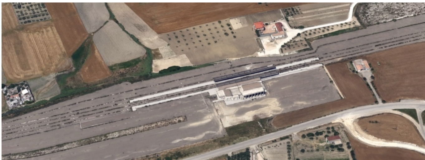
La stazione incompiuta di Matera La Martella.
