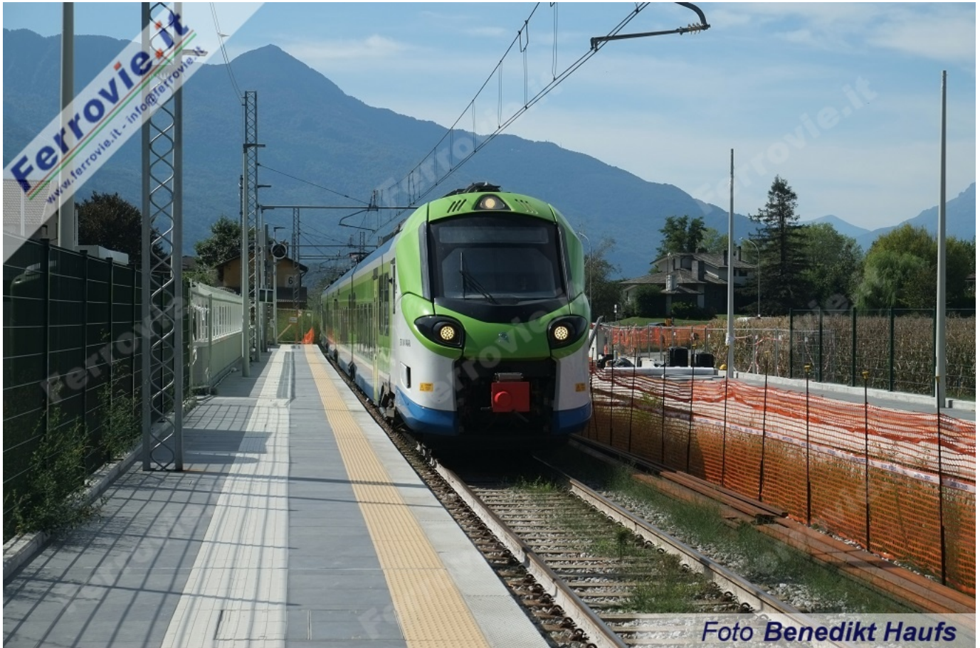
3. L'ETR.104-048 come Regionale 10166 Colico - Chiavenna fa il suo ingresso nella stazione di Dubino, dove sono in costruzione il nuovo binario 2 e il sottopassaggio. Foto Benedikt Haufs, 13 settembre 2022)
