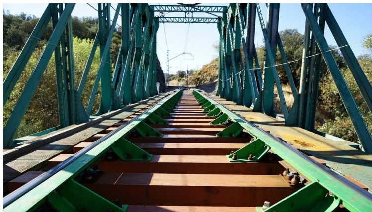
Ponte metallico sovrastante il fiume Guarrizas armato con traversine sperimentali in materiale plastico.
