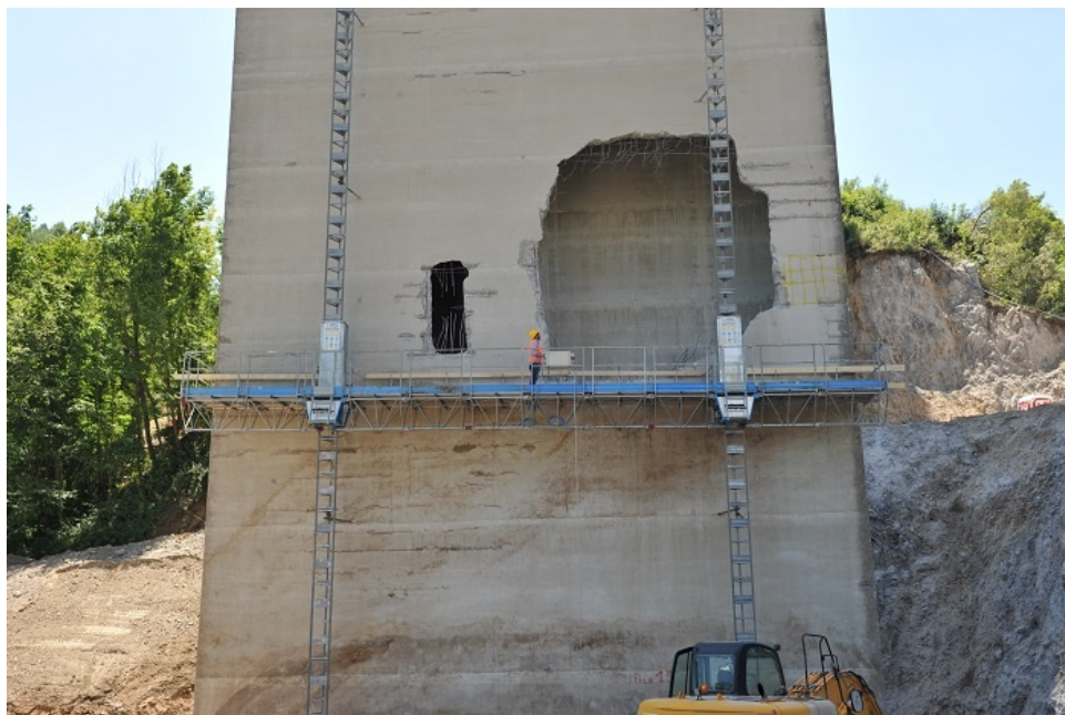
11 Lavori di riparazione e rimozione porzione pila 13 danneggiata dal crollo della campata. (Foto Anas)
