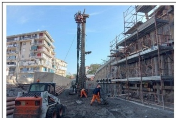
3 Realizzazione micropali di fondazione muri tipo 2
