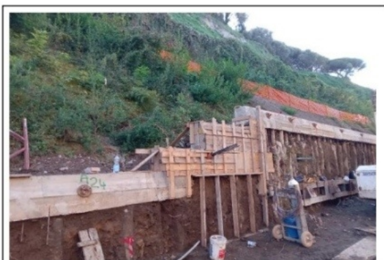
3 Completamento cordolo sezione 47-48
