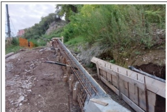
1 Armatura tratto cordolo sezione 42-44
