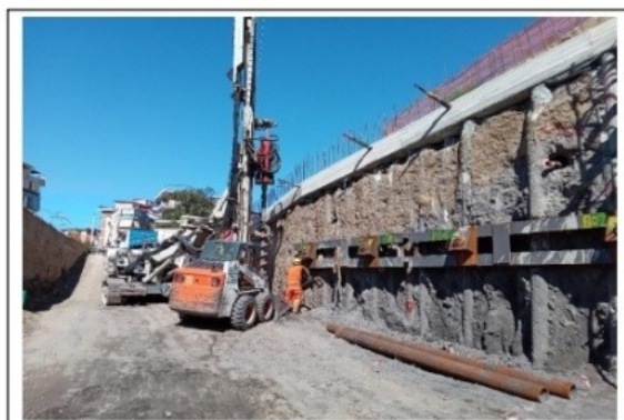
1 Realizzazione micropali di fondazione muri tipo 2
