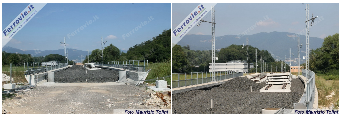
3/4. I cantieri della linea Arcisate - Stabio. (Foto Maurizio Tolini, 03 agosto 2015)
