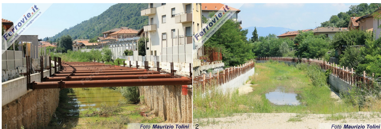
1/2. I cantieri della linea Arcisate - Stabio. (Foto Maurizio Tolini, 03 agosto 2015)
