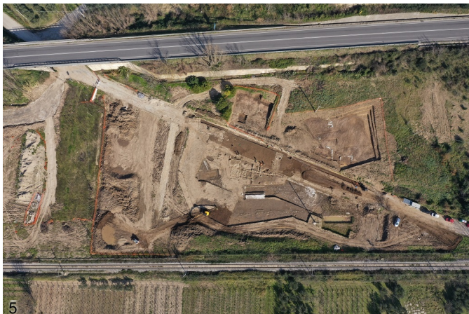
5. Scavi archeologici cantiere galleria Tuoro Sant'Antuono.
