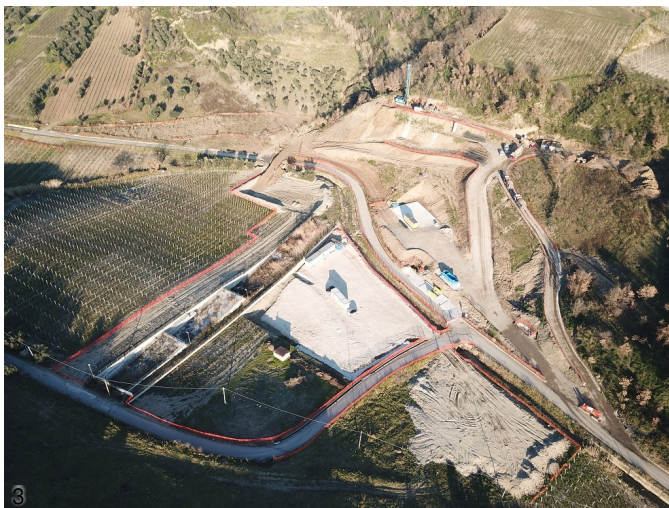
3. Cantiere galleria San Lorenzo.
