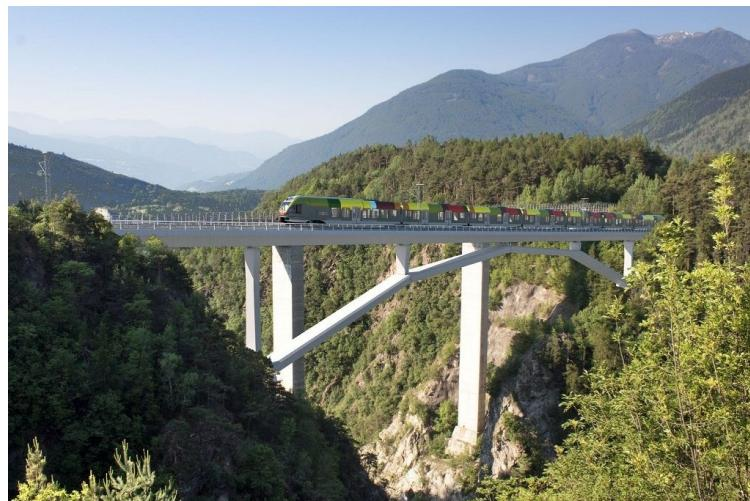
Nel dettaglio, l'intervento consiste nella realizzazione di un nuovo tracciato di 3,8 chilometri, a singolo binario. Distaccandosi dalla linea storica Verona-Brennero, la nuova linea sotto attraverserà prima l'autostrada A22 e la strada statale 12 e poi travalicherà il fiume Isarco su un nuovo ponte ad arco, arrivando così a congiungersi con la linea Fortezza-San Candido, in prossimità del quale verrà realizzata la nuova fermata di Naz-Sciaves.
