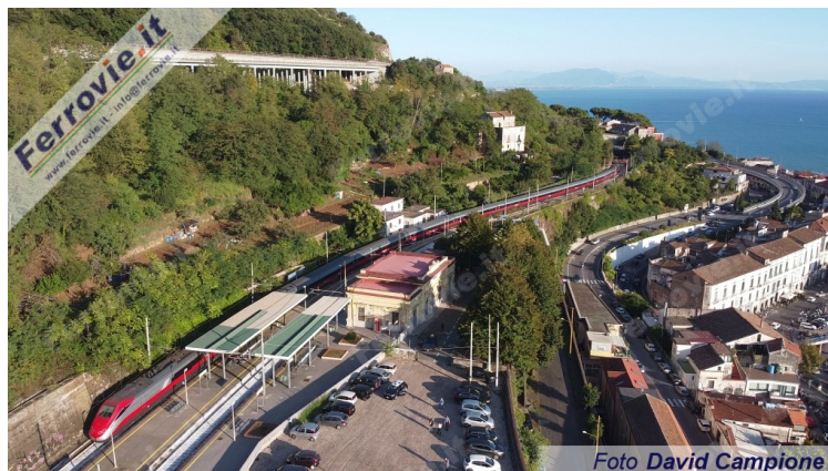
4. La stazione di Vietri sul Mare sorge a poche decine di metri dalla piazzetta centrale del paese, collegata mediante ascensore. In foto un ETR.500 Frecciarossa in discesa verso Salerno, nei giorni in cui la Linea Monte del Vesuvio era chiusa per lavori, nei pressi della galleria Santa Lucia. (Foto David Campione, 02 ottobre 2020)
