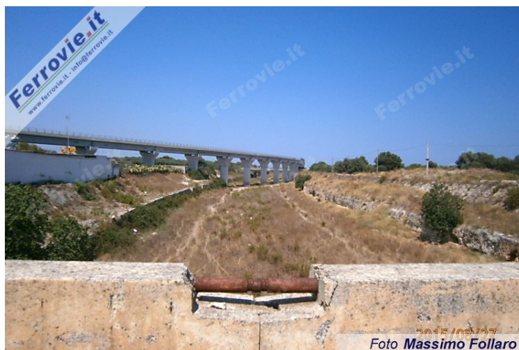
6. Una visione dello snello e alto viadotto ferroviario nel punto, verso il centro di Bari, scavalca il canale scolmatore Lamasinata: sullo sfondo l'area dello Stadio San Nicola. (Foto Massimo Follaro, 27 agosto 2015)
