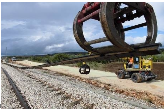
1. Lavori di rimozione del vecchio binario, in vista della posa sul sedime adiacente. (Foto Ferrovie del Gargano, ottobre 2015)
