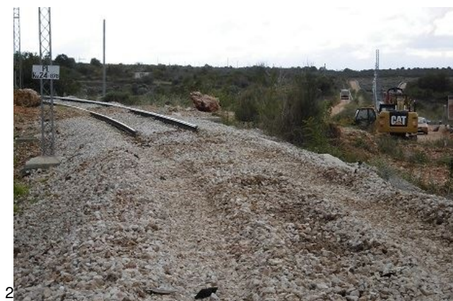
1. Lavori di rimozione del vecchio binario, in vista della posa sul sedime adiacente. (Foto Ferrovie del Gargano, ottobre 2015)
