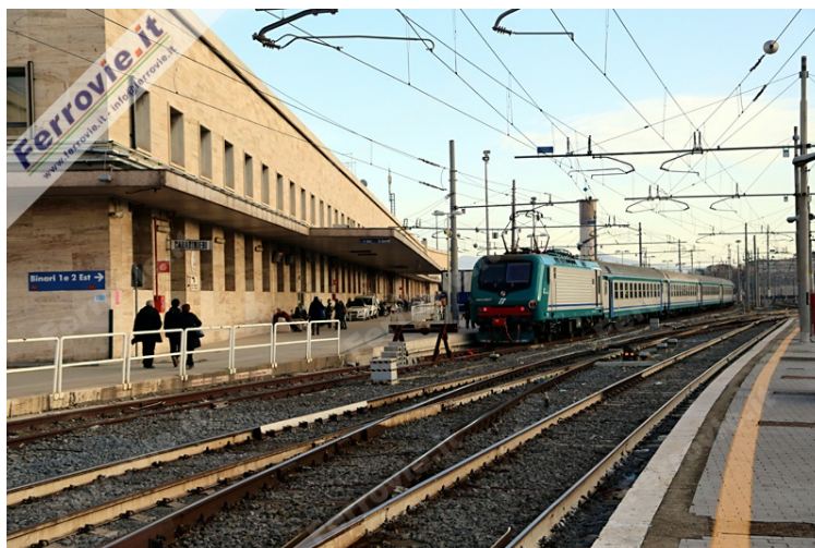
Il marciapiede dei binari 1 e 2 Est di Roma Termini saranno protetti da una pensilina lunga 240 metri.
