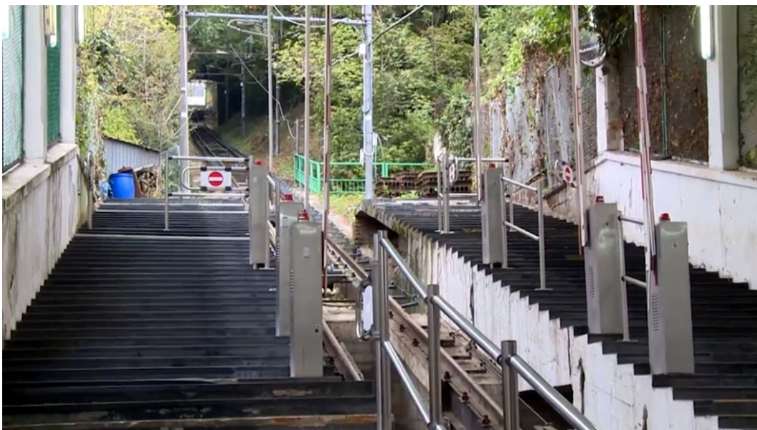
22 La stazione di Mercogliano, chiusa come tutto l'impianto dal 2012. Foto Regione Campania, 05 ottobre 2015
