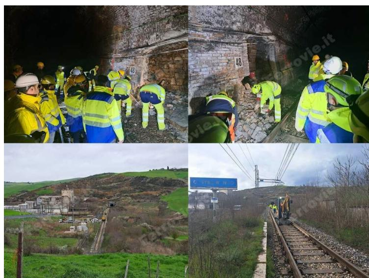
Parallelamente proseguono le attività di trivellazioni profonde, fino a 100 metri, necessarie al monitoraggio geologico. L'obiettivo è individuare la natura e la caratterizzazione dei terreni, la profondità della superficie di scorrimento e la quantità d'acqua presente nei sottosuoli.
