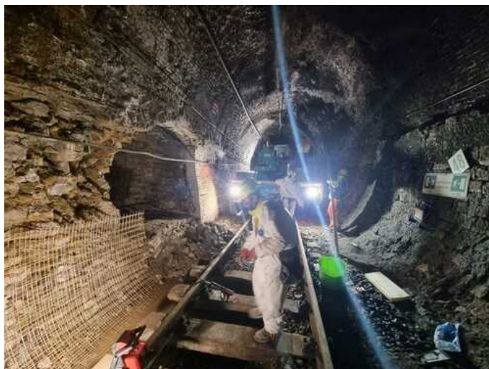
Operai di RFI al lavoro nella galleria Starza, per la ricostruzione dell'arco rovescio e del pozzo di ventilazione.
