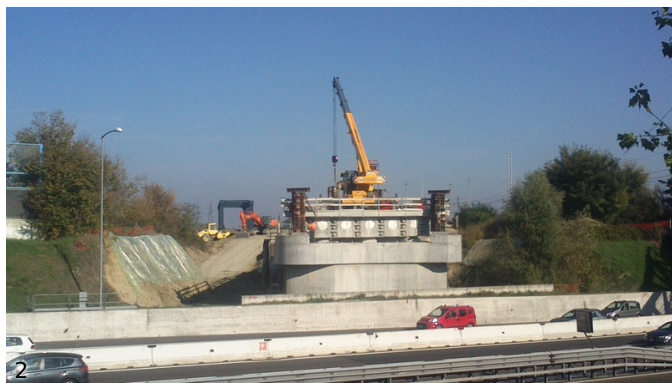
2 Impalcato su cui poggerà una delle due estremità del ponte, che scavalcherà A14 e tangenziale di Bologna. (Foto Gruppo FS)
