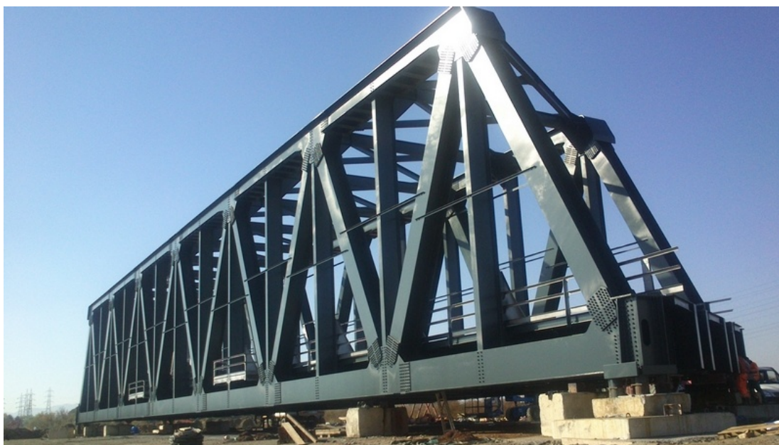
1 La campata metallica in attesa del varo. (Foto Gruppo FS)
