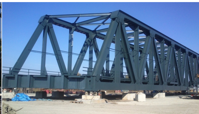
2 Impalcato su cui poggerà una delle due estremità del ponte, che scavalcherà A14 e tangenziale di Bologna. (Foto Gruppo FS)
