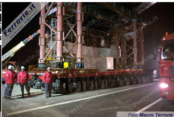
5. Particolare dell'impalcato sul carrello, che sorregge il ponte durante lo spostamento. (Foto Mauro Terrone, 14 novembre 2015)
