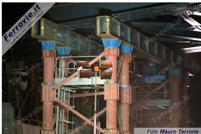
5. Particolare dell'impalcato sul carrello, che sorregge il ponte durante lo spostamento. (Foto Mauro Terrone, 14 novembre 2015)
