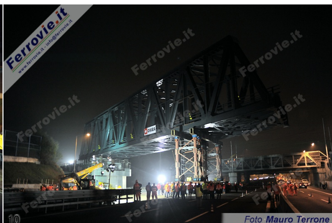
9. Nel cuore della notte autostrada e tangenziale sono completamente chiuse ed il ponte avanza lentamente verso l'altra sponda. (Foto FS Italiane)
