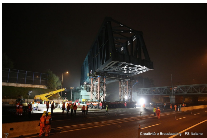
7. Altra inquadratura che mette in risalto l'ampiezza del cantiere. (Foto FS Italiane)
