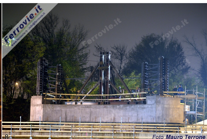
6. Il carrello con 24 assi per 4 file, pronto per il "viaggio" per attraversare le corsie stradali. (Foto Mauro Terrone, 14 novembre 2015)
