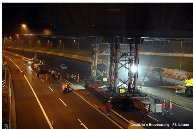
9. Nel cuore della notte autostrada e tangenziale sono completamente chiuse ed il ponte avanza lentamente verso l'altra sponda. (Foto FS Italiane)
