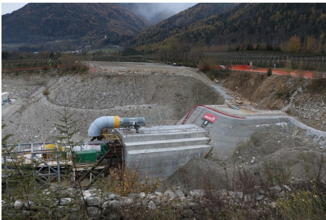
1. Il cantiere del passante ferroviario della Val di Riga. Foto USP/Ingo Dejacq
