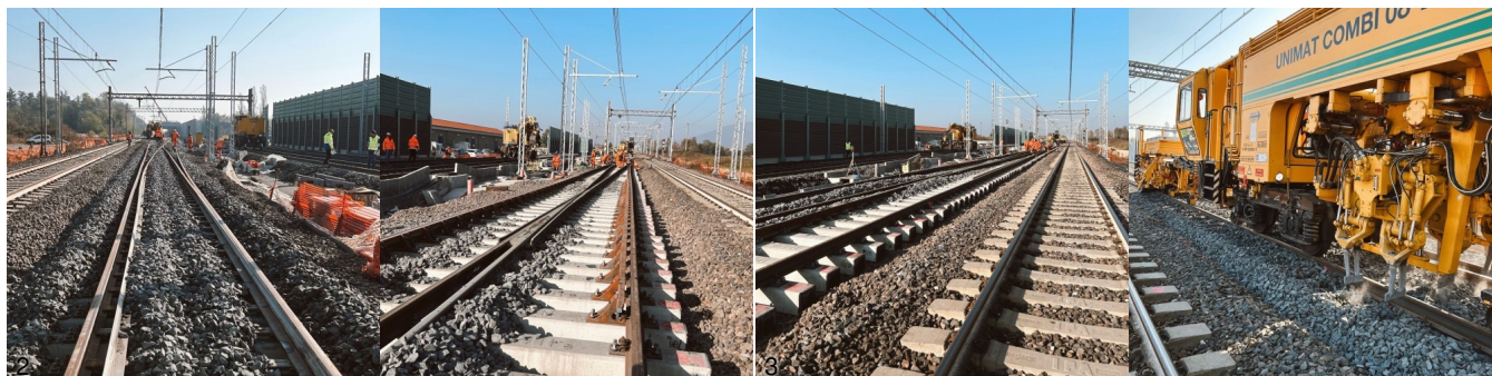
2/3. Lavori di posa dei deviatori, per la realizzazione del bivio ferroviario a Mazzano, in provincia di Brescia.
