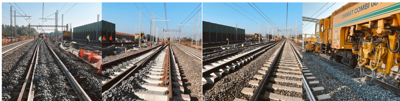
2/3. Lavori di posa dei deviatori, per la realizzazione del bivio ferroviario a Mazzano, in provincia di Brescia.
