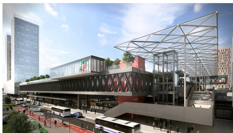
Il progetto prevede la costruzione di un nuovo hub intermodale, con un'opera di scavalco sopra i binari larga 31 metri e lunga 100 metri. Questa struttura fungerà da percorso ciclopedinale tra Mestre e Marghera e da connessione di stazione, con spazi destinati a servizi per i viaggiatori e varchi di passaggio.
