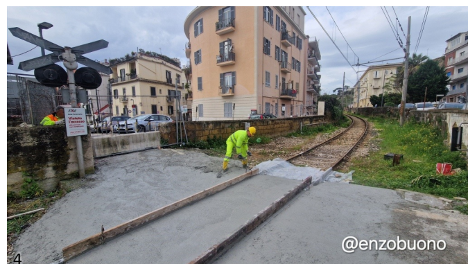
3. Lavori di copertura delle rotaie in corrispondenza del passaggio a livello pedonale di Pozzuoli, lato Arco Felice. (Foto Enzo Buono, 07 gennaio 2025)
