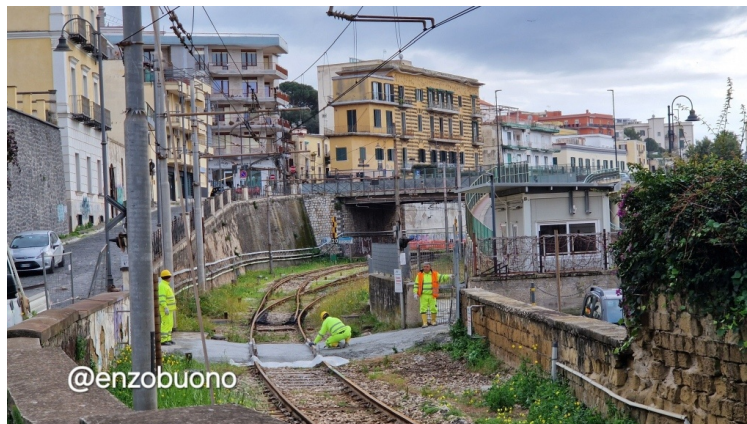
3. Lavori di copertura delle rotaie in corrispondenza del passaggio a livello pedonale di Pozzuoli, lato Arco Felice. (Foto Enzo Buono, 07 gennaio 2025)
