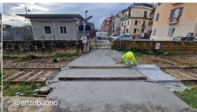
3. Lavori di copertura delle rotaie in corrispondenza del passaggio a livello pedonale di Pozzuoli, lato Arco Felice. (Foto Enzo Buono, 07 gennaio 2025)
