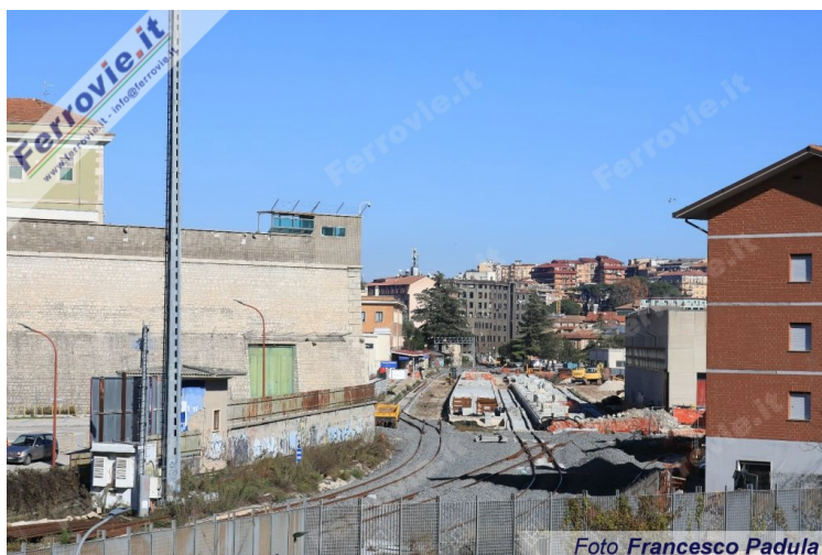
2. Lavori presso la stazione di Campobasso: rifacimento banchine, binari e nuovo piano schematico. (Foto Francesco Padula, 17 novembre 2024)
