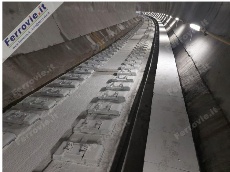
**2. Strutture in cemento armato assemblate direttamente all'interno della galleria per ridurre le vibrazioni dovute al transito dei convogli.**
