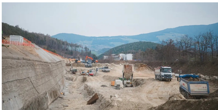
Lavori in corso per le linee aeree e l'adeguamento dei binari sulla linea esistente (nella foto nei pressi di Sciaives) per l'ammodernamento della ferrovia della Val Pusteria. (Foto USP/STA)
