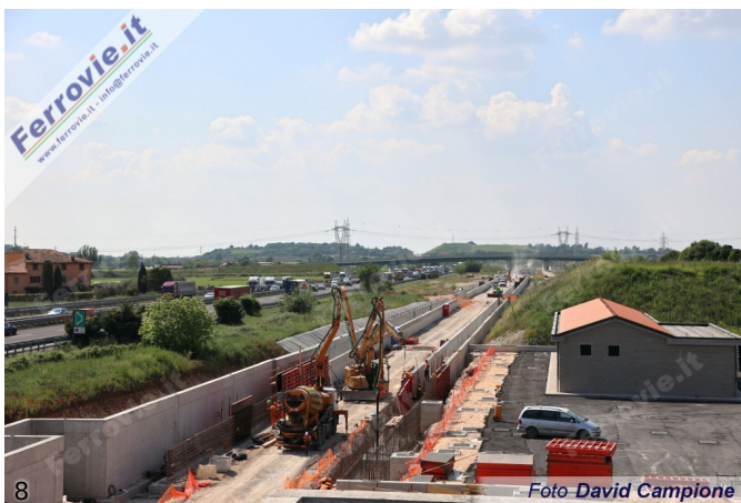
8. Opere civili in completamento presso Lonato del Garda. Sullo sfondo si riconosce un mezzo d'opera in azione per il livellamento delle rotaie sul ballast. (Foto David Campione, 14 maggio 2025)
