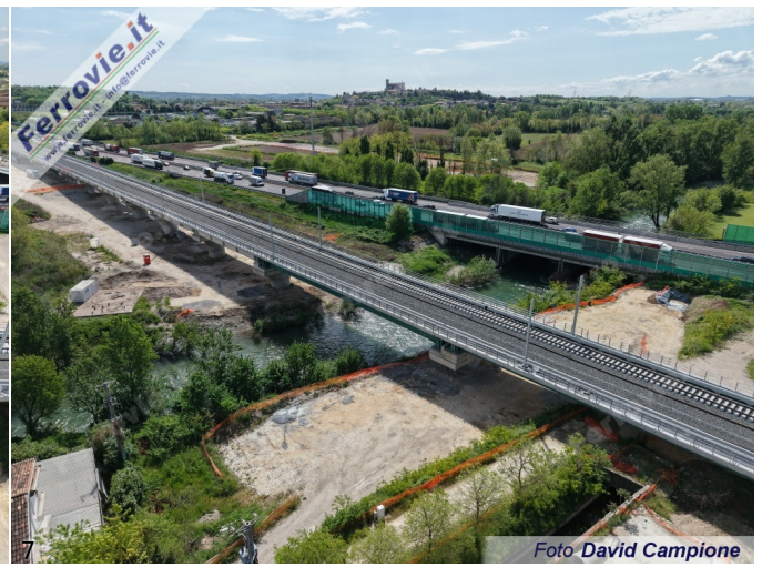
7. Vista completa dello stesso viadotto, che alla data della foto presentava l'armamento parzialmente posato. (Foto David Campione, 24 aprile 2025)
