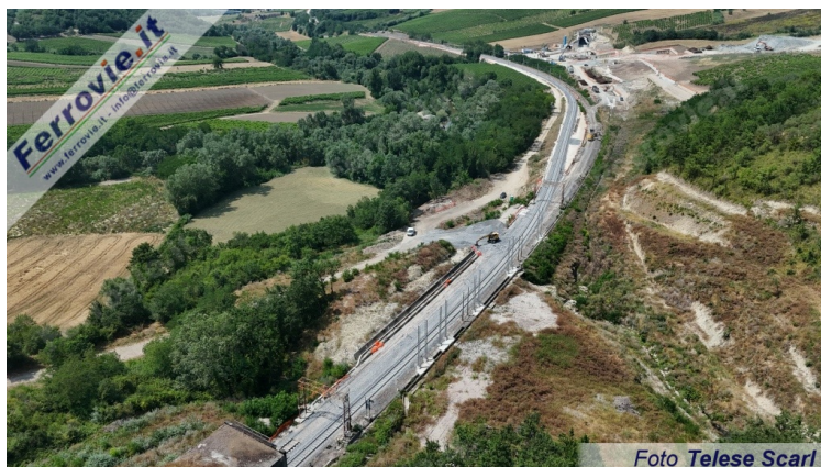
1. La "Deviata E", variante di tracciato tra Vitulano e Ponte, attivata il 15 giugno. In basso a sinistra si riconosce il portale della galleria Mascambroni. (Foto Telese Scarl)
