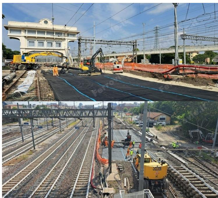
Quella appena conclusa è una delle fasi di un unico progetto di manutenzione e impermeabilizzazione del ponte, lungo circa 30 metri e largo 70, su cui corrono 15 binari. Le fasi successive sono in programma per il 2026, 2027 e 2028, per un investimento complessivo di circa 5,6 milioni di euro (di cui 1,4 milioni per i lavori appena completati).
