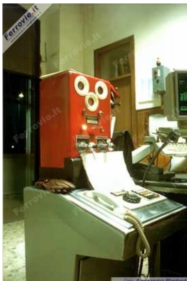
1. Istrumento di blocco nella sala DM di Codogno. Essendo la prima stazione dalla quale si dirama la linea per Cremona-Mantova, aveva un solo apparato corrispondente con Pizzighettone. Le due maniglie venivano utilizzate per chiedere o concedere il consenso. Oggi, la linea è esercita con blocco elettrico contaassi e l'istrumento è stato rimosso. (Foto Alessandro Manfredi, 23 novembre 1994)
