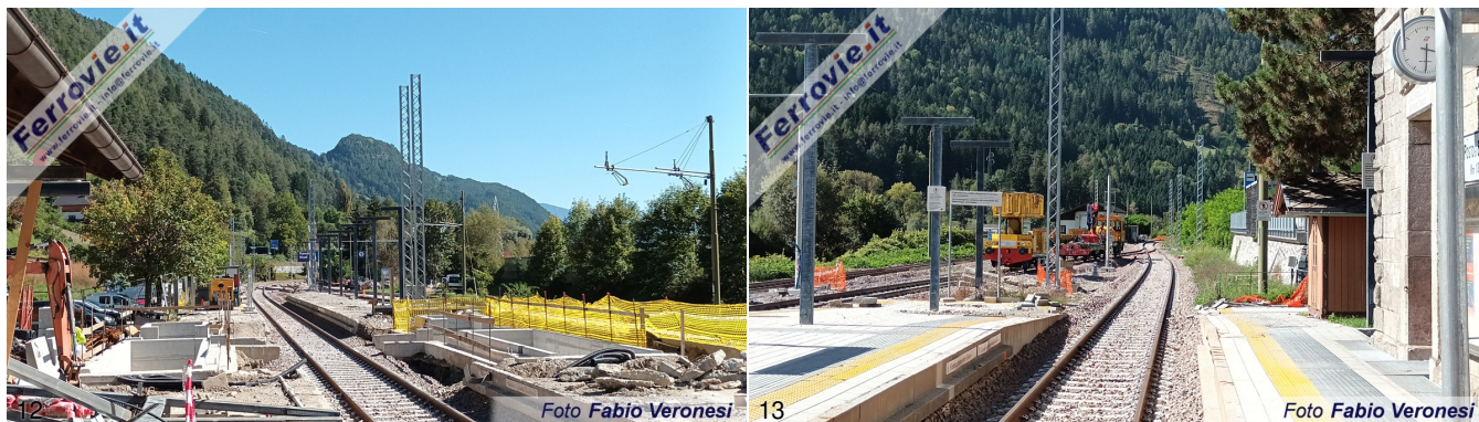
12. La stazione di Vandoies con in evidenza i lavori per la realizzazione del sottopasso. (Foto Fabio Veronesi, 18 settembre 2025)
