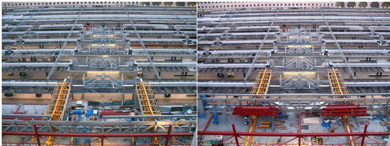
1. L'impalcato del parcheggio sui binari di Roma Termini prima del varo della prima piastra... (Foto Gruppo FS, 16 gennaio 2016)
