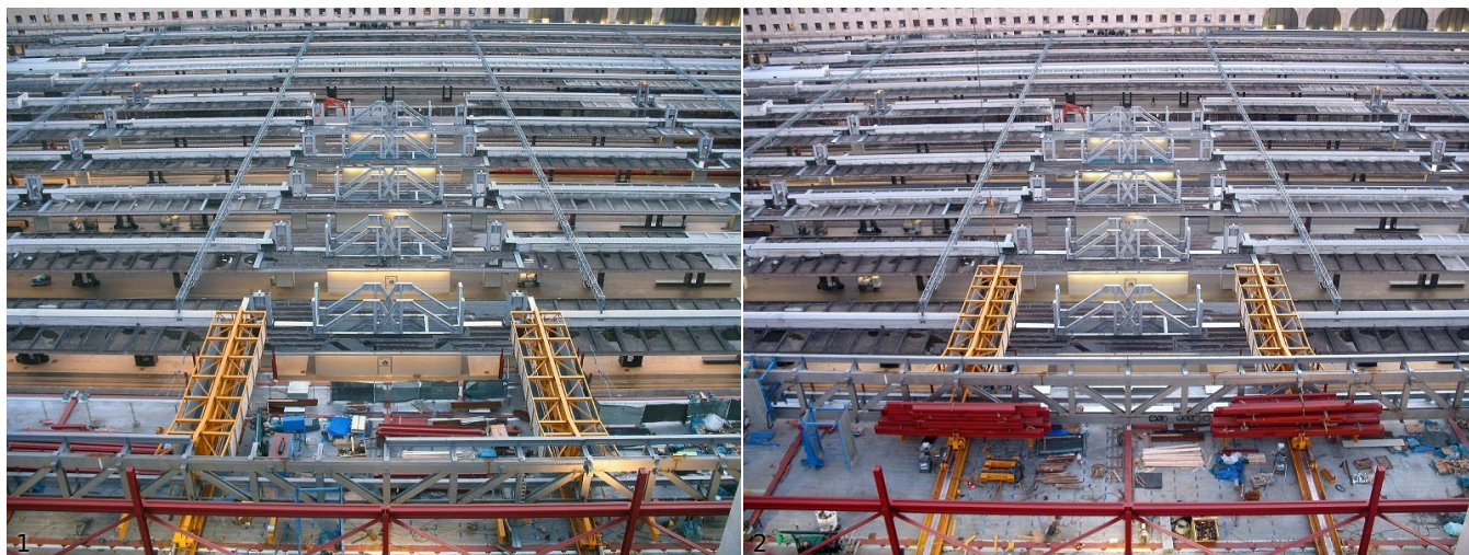
1. L'impalcato del parcheggio sui binari di Roma Termini prima del varo della prima piastra... (Foto Gruppo FS, 16 gennaio 2016) 2. ...e subito dopo il varo della stessa. (Foto Gruppo FS, 17 gennaio 2016)
