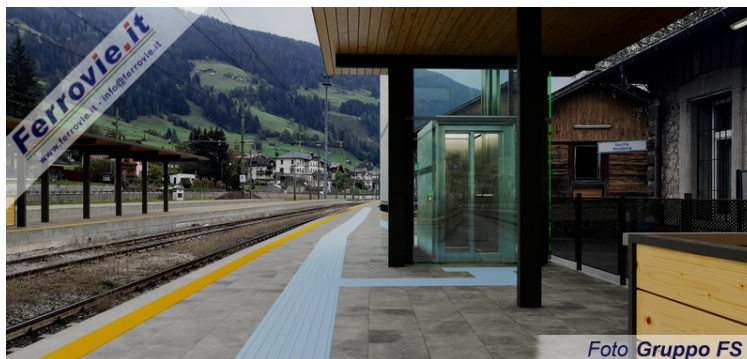
Tra i punti centrali dei lavori previsti dall'accordo: marciapiedi rialzati, per garantire un accesso senza barriere ai treni. (Foto Gruppo FS)
