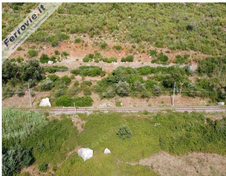
La frana che nel 2012 ha investito la ferrovia Priverno-Terracina, decretandone la chiusura.
