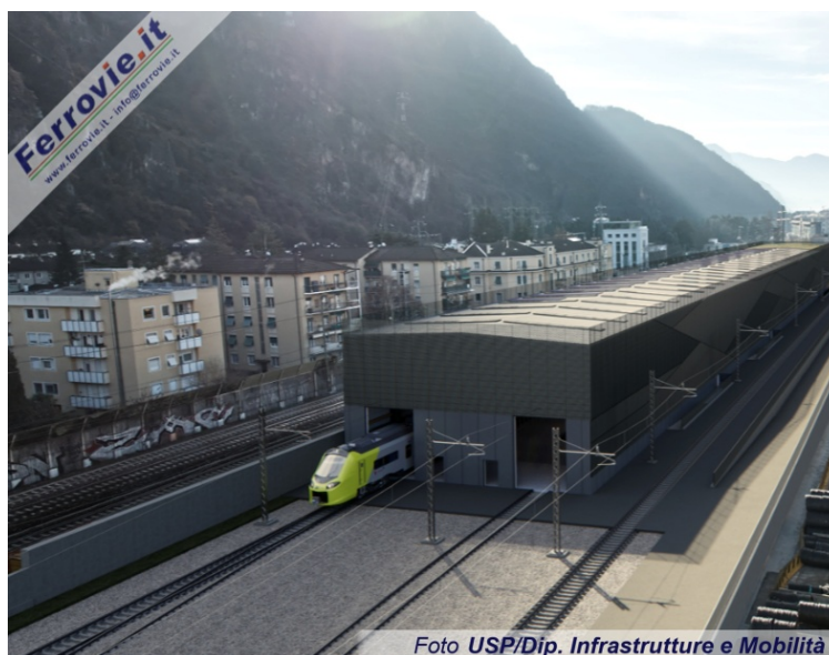
Foto USP/Dip. Infrastrutture e Mobilità
