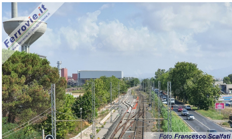
La linea Campoleone-Nettuno con il nuovo raccordo ferroviario per Overall, che ha origine nella stazione di Campo di Carne. (Foto Francesco Scafati, 22 luglio 2026)
