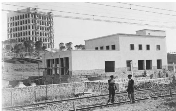
Lavori di costruzione della nuova Stazione Magliana comune alla Ferrovia Roma-Lido (i cui binari sono in primo piano) e alla Ferrovia E.42 (sede dei binari prossima al fabbricato viaggiatori). Sullo sfondo il Palazzo della Civiltà Italiana in corso di finitura - Anno 1940 (Foto EUR Spa)
