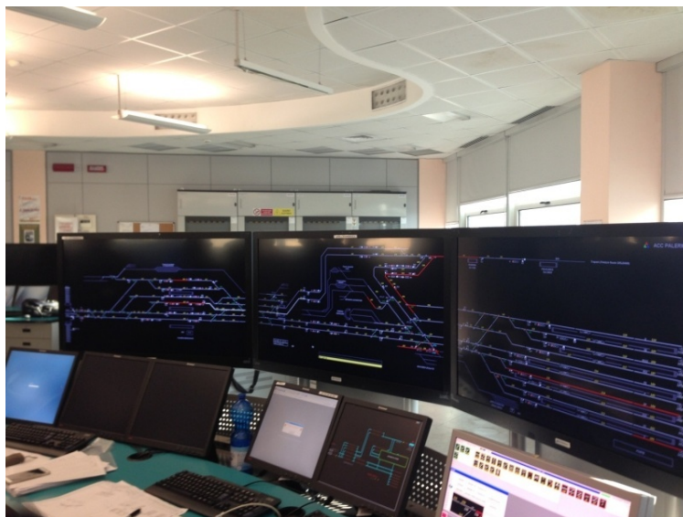
5. L'Apparato Centrale Computerizzato di Palermo (Foto Gruppo FS)
