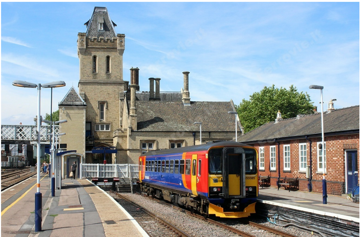
8. Automotrice 153 385 di East Midlands Trains, uguale a quella che più tardi effettuerà il treno delle 14:27 per Grimsby, sullo sfondo del caratteristico fabbricato viaggiatori di Lincoln Central, del 1848. (Foto Jacopo Fioravanti, 22 agosto 2015)
