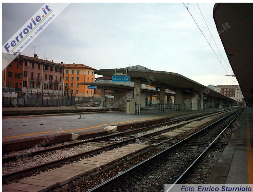
3. Vista opposta verso il ponte di Galliera che permette di notare sulla sinistra come tutti i fabbricati una volta adiacenti al binario 15 siano stati demoliti ormai da alcuni anni per i lavori dell'Alta Velocità. (Foto Enrico Sturniolo, 27 marzo 2004)
