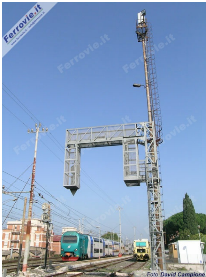
22 La torre-faro di Settebagni. Sulla sommità è riconoscibile il ripetitore di segnale GSM-R. (Foto David Campione, 25 ottobre 2004)
