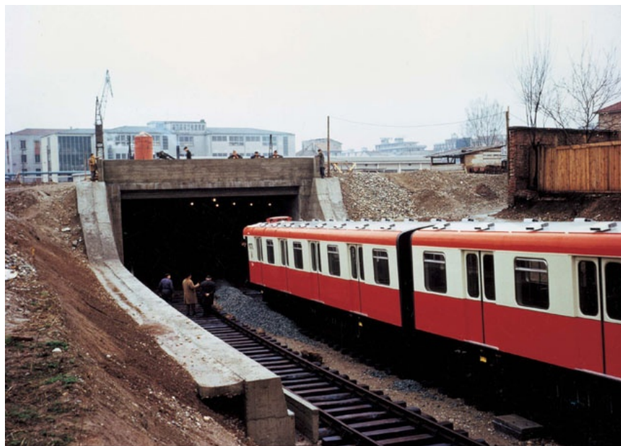
ATM Aprile 1963: deposito Precotto. Una delle prime vetture immesse in galleria.
