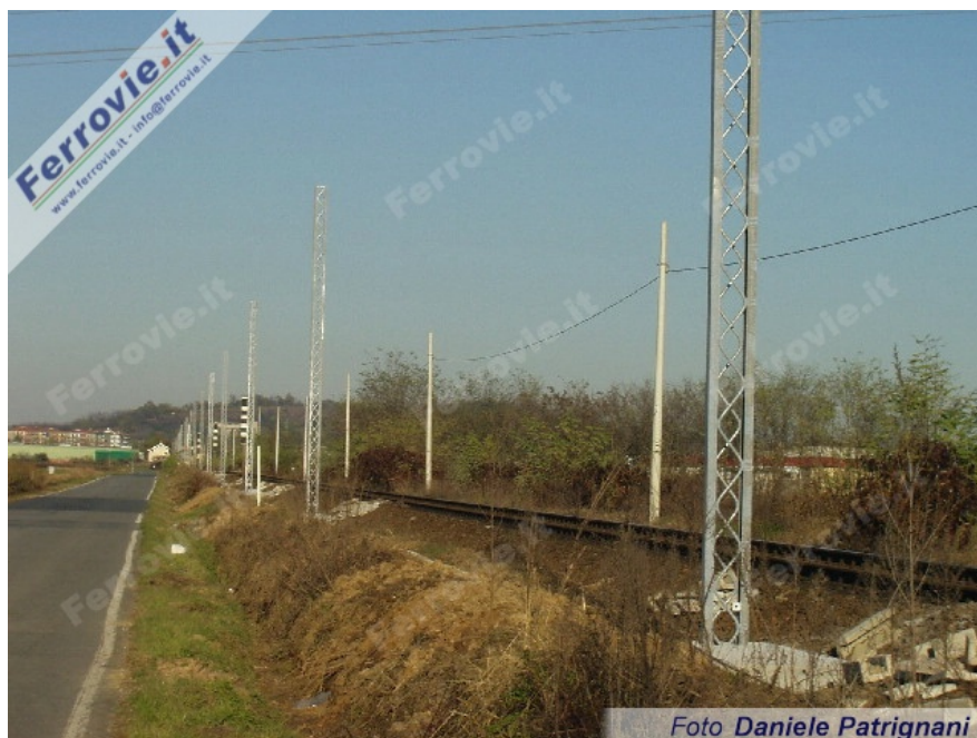
2. Tratto di linea tra Rodallo e Caluso. Qui si può notare come i pali utilizzati siano del tipo a traliccio LS. (Foto Daniele Patrignani, 21 novembre 2004)
