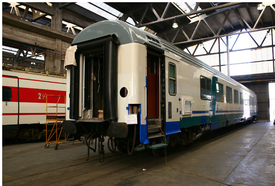
Carrozza Gran Confort 50 83 18-98 545-6 in lavorazione nello stabilimento Firema Trasporti. Le aperture eseguite sulla testata delle carrozze, riguardano la modifica per l'applicazione dei fanali coda treno. (Foto David Campione, 5 gennaio 2005)
