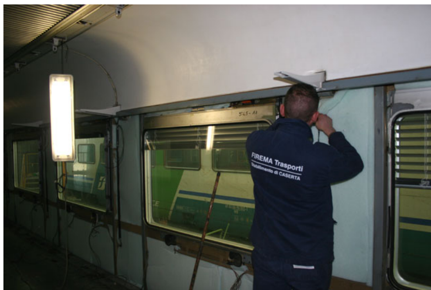
Si lavora sulla stessa carrozza della foto precedente per il rimontaggio dei pannelli di rivestimento. Le modifiche hanno comportato, tra l'altro, il passaggio alla base dei finestrini di una linea di alimentazione a 220 Volt per le prese di corrente alloggiare nei tavolini. (Foto David Campione, 5 gennaio 2005)
