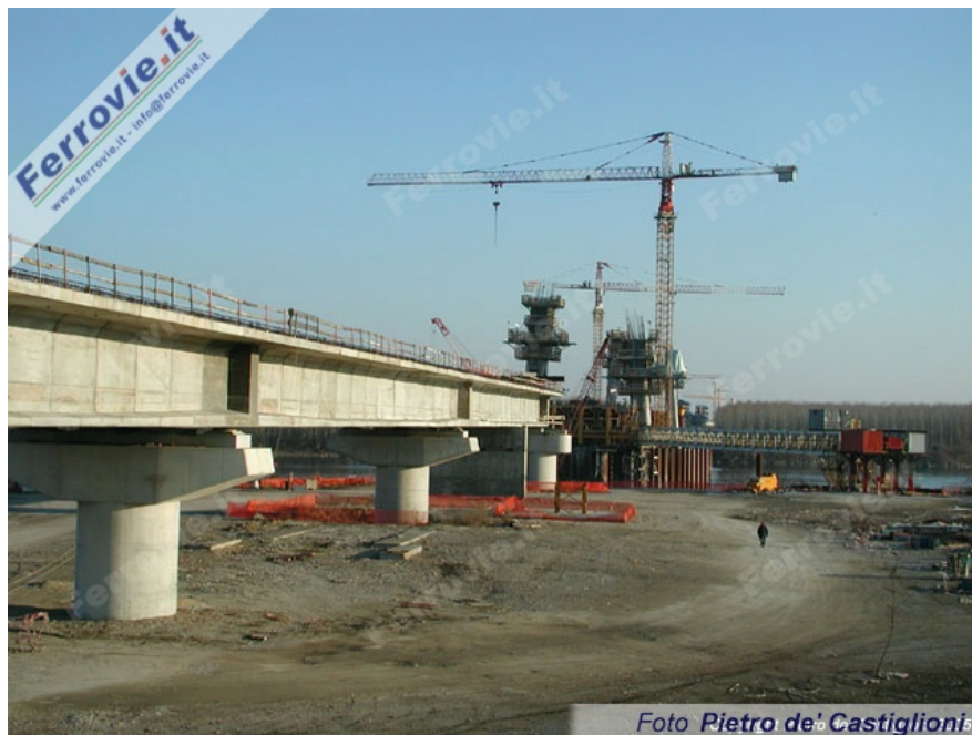
4. Altra inquadratura del viadotto Piacenza, qui nella parte terminale. Sullo sfondo il fiume Po con il cantiere del ponte in costruzione. Foto Pietro de' Castiglioni, 30 gennaio 2005
