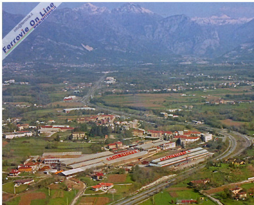
Veduta aerea dello stabilimento di CostaRail, che sorge nel comune di Costa Masnaga, in provincia di Lecco (Foto CostaRail)
