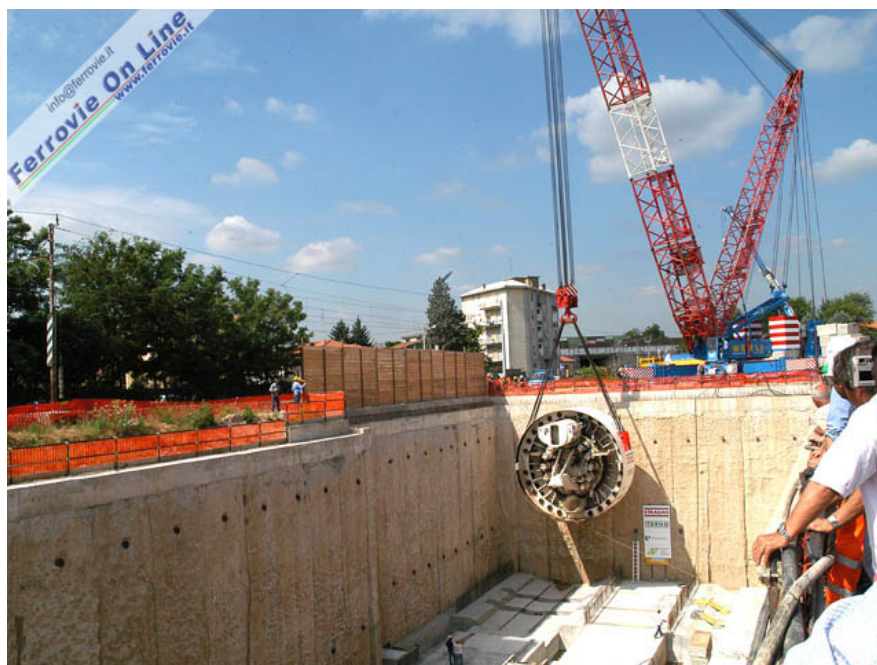
1 Il posizionamento dello scudo della fresa nel punto di inizio dei lavori di scavo. (Foto Trainsphoto.it , 6 luglio 2005)
