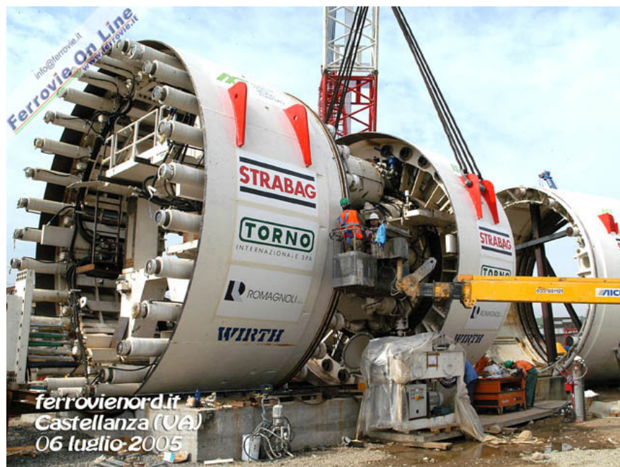
21 componenti della fresa utilizzata per lo scavo del tunnel di Castellanza. (Foto Trainsphoto.it, 6 luglio 2005)
