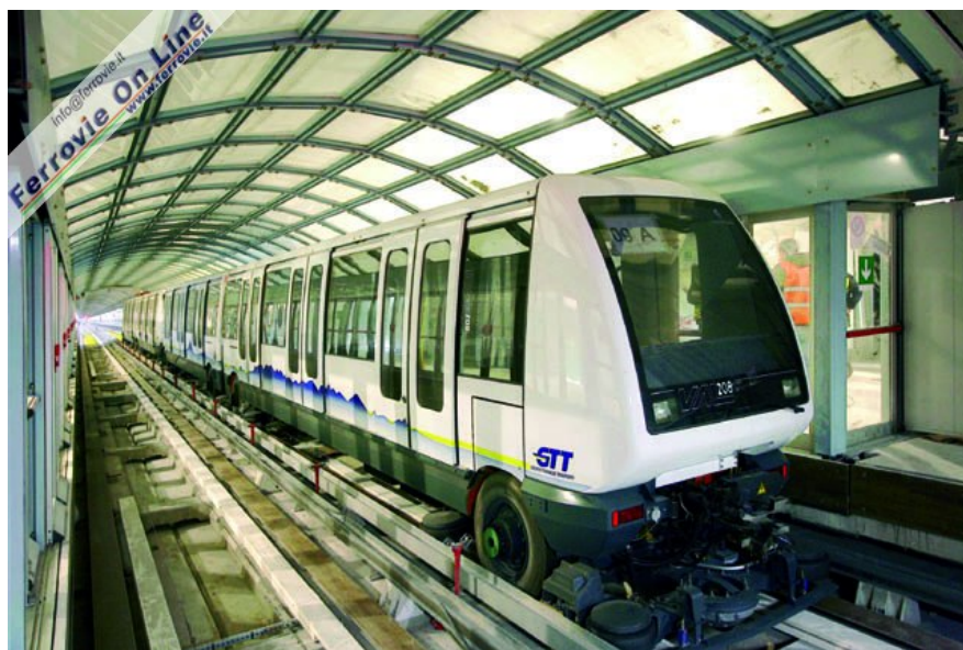
1. Un treno nel tunnel vetrato, in sosta in banchina. (Foto Michele D'Ottavio - GTT, gennaio 2006)
