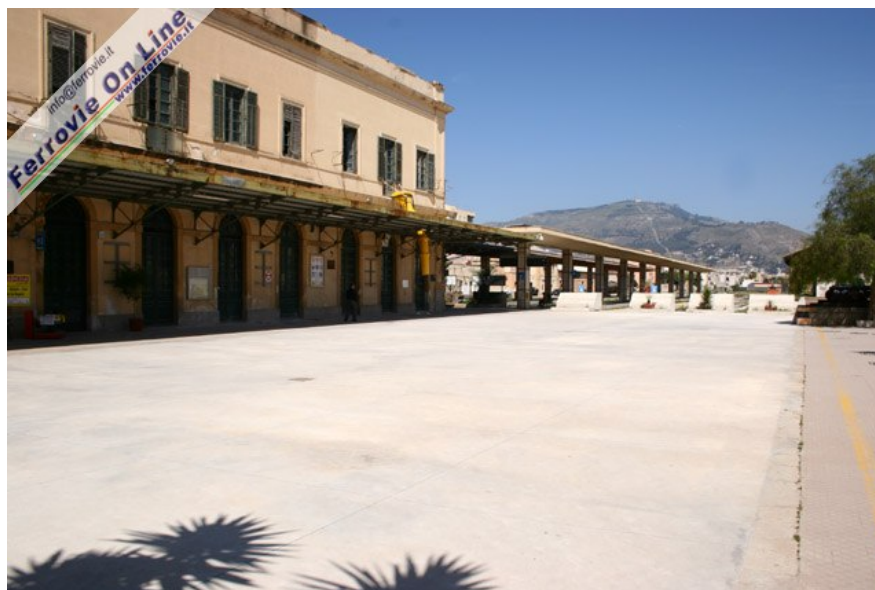
1. L'ampio piazzale che si è ottenuto nella stazione di Trapani, dopo il taglio dei quattro binari che si attestavano dinanzi il fabbricato viaggiatori. Foto David Campione, 1 maggio 2006
