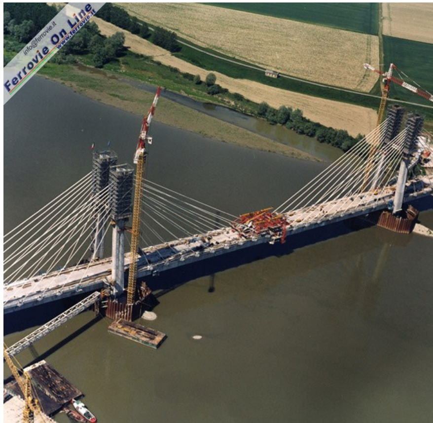
2 a Vista aerea del manufatto, ripreso durante il completamento dei lavori di costruzione. (Foto TAV, giugno 2006)
