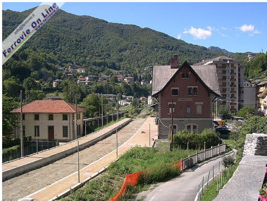
24 nuovi marciapiedi della stazione di Pessinetto. Anche qui deve ancora iniziare la posa dei binari. Foto Andrea Borgnino, 30 agosto 2006
