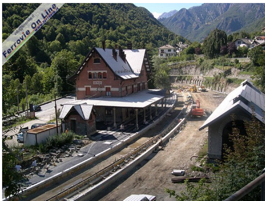
1. Vista del piazzale di stazione di Ceres durante i lavori di rifacimento dei marciapiedi a servizio dei due futuri binari. Sulla destra la rimessa. Foto Andrea Borgnino, 30 agosto 2006
