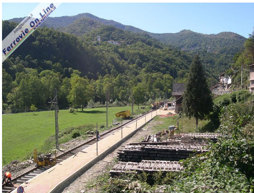
3 Il cantiere per la posa dei nuovi binari a Traves. Qui sono già in opera i pali della linea aerea. (Foto Andrea Borgnino, 30 agosto 2006)
