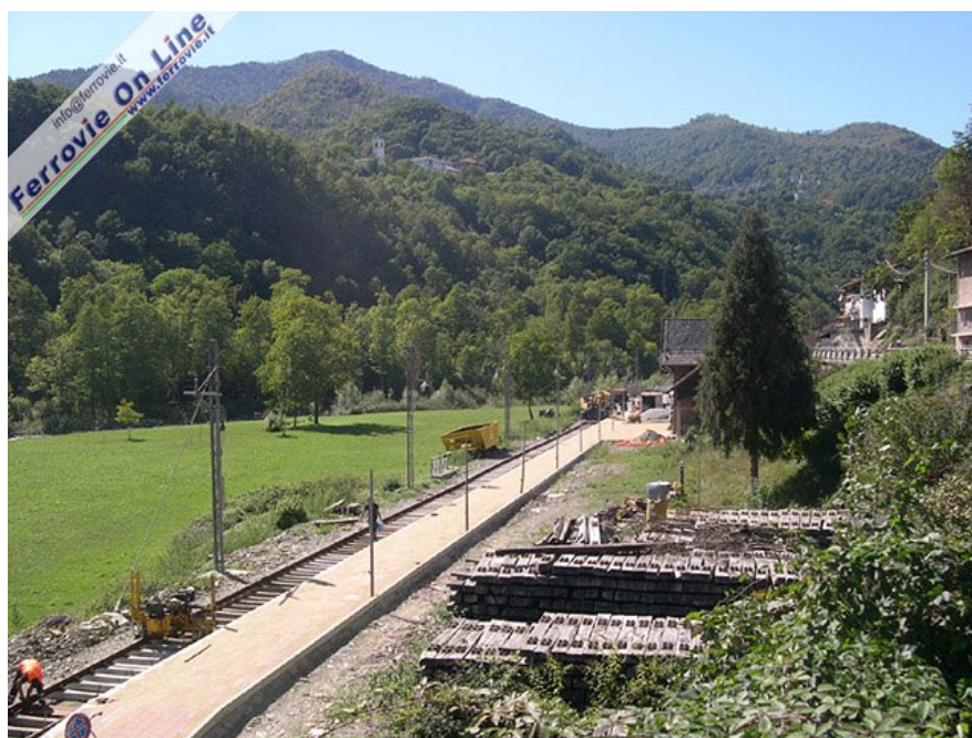
33 Il cantiere per la posa dei nuovi binari a Traves. Qui sono già in opera i pali della linea aerea. Foto Andrea Borgnino, 30 agosto 2006
