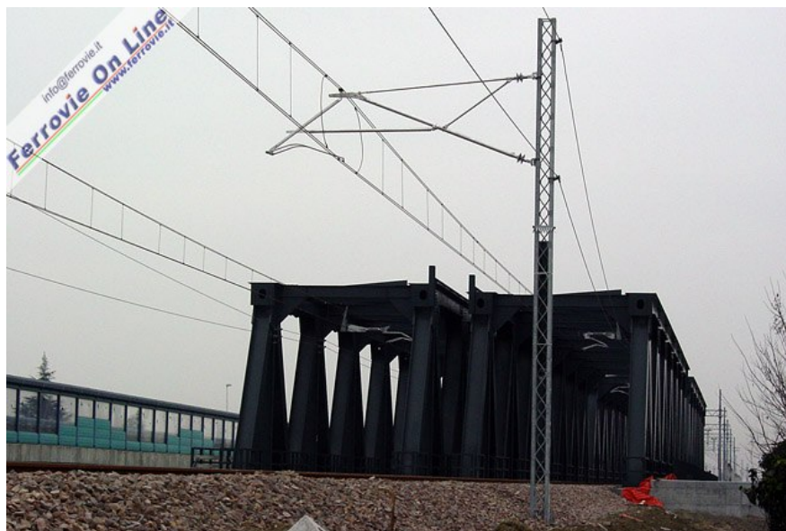
2. I due ponti a travate metalliche sul fiume Brenta della linea AV/AC Padova - Mestre. (Foto Fabio Veronesi, 4 gennaio 2007)
